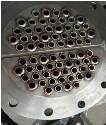
图3 换热管数量较多时施焊图
