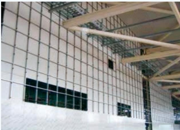
图2 龙骨结构骨架
