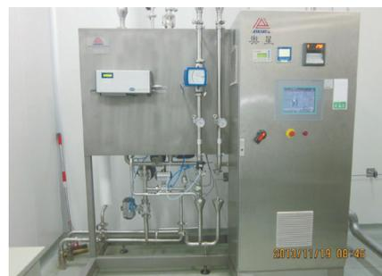
图4 热储存、独立循环系统的实践
